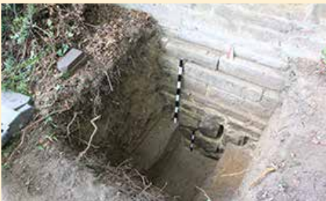
Probegrabung am Fundament
