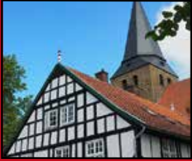
Sanierung Pfarrstraße 2 Seite 13
