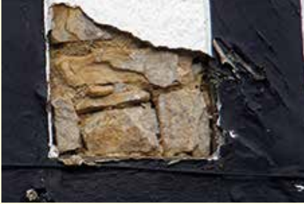
Die originale Bruchsteinfüllung Foto: W. Bosch
